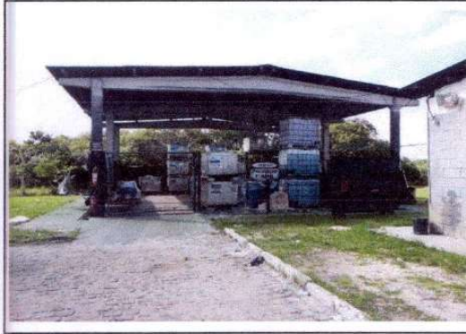
VISTA DA MANUNTEÇÃO E DEPÓSITO DE TINTAS
