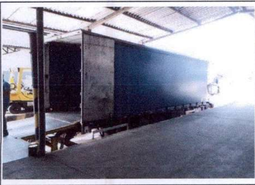
VISTA DO GALPÃO PRINCIPAL
