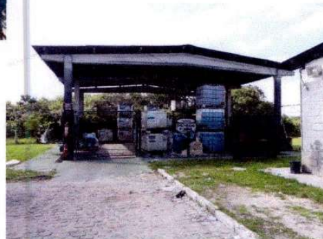
Vista da Casa de Tintas e Óleo - armazenamento no imóvel
