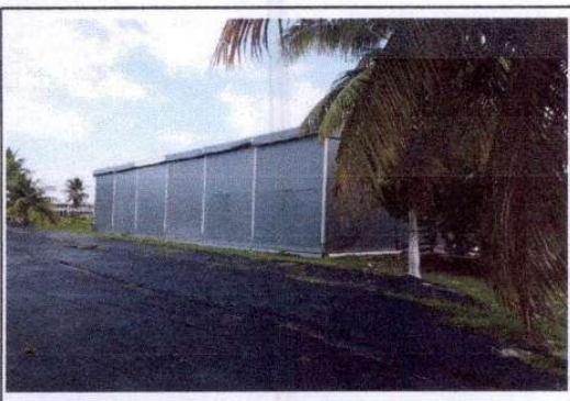
VISTA DE GALPÃO PROVISÓRIO / SUPRIMENTOS
