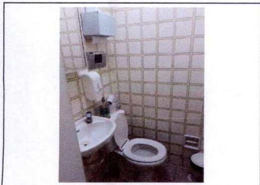
VISTA DO SANITÁRIO FOTO 43
