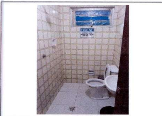
VISTA DO SANITÁRIO FOTO 46
