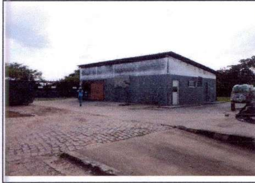
VISTA DA MANUNTEÇÃO E DEPÓSITO DE TINTAS
