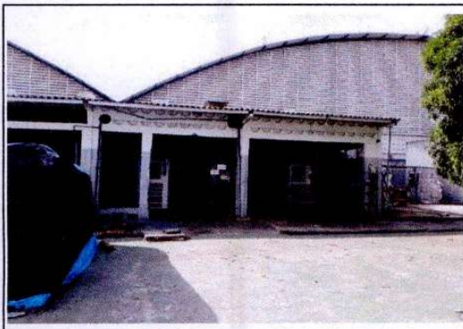
VISTA DA SUBESTAÇÃO FOTO 9
