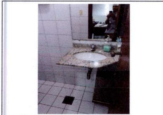
VISTA DO SANITÁRIO
